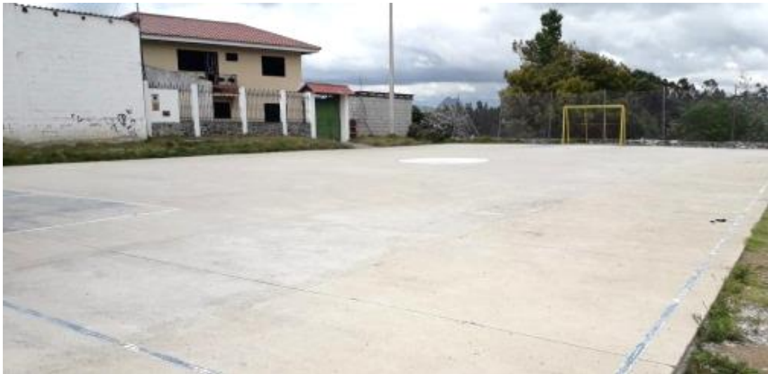
Fotografía 29: Cancha Multiuso - Comunidad La Ramada
