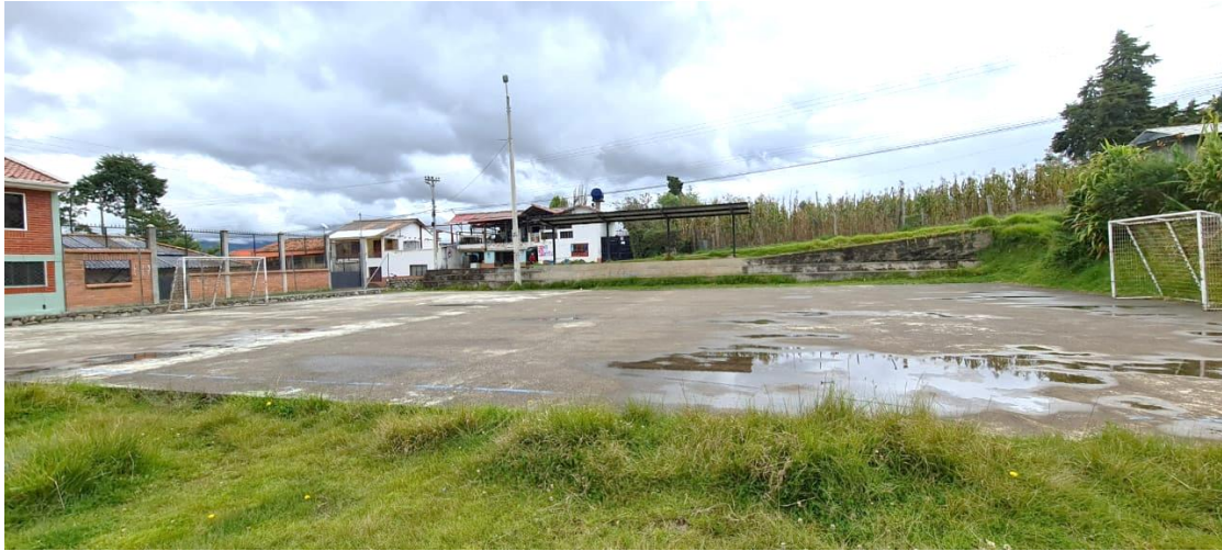
Fotografía 26: Cancha Multiuso - Comunidad de Guachun
