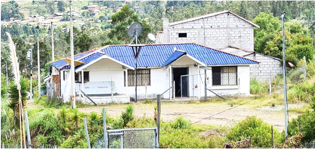
Fotografía 41: Casa Comunal e Infocentro – Comunidad de Bellavista
