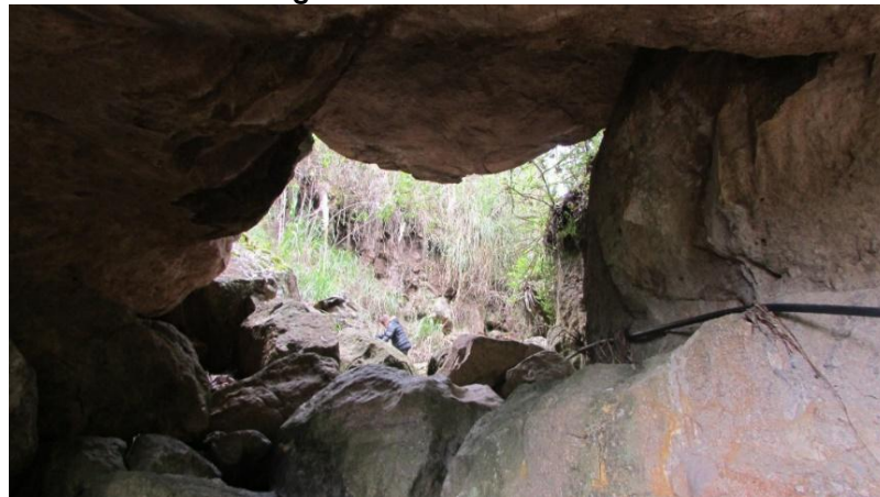
Fotografía 2.3.7 Puente de Piedra
