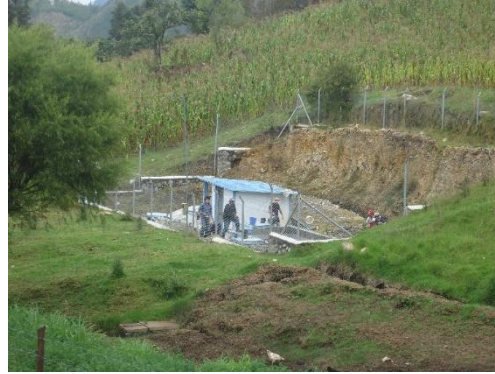
Fotografía 2.4.4 Planta de tratamiento de agua de la comunidad Pastopamba.
