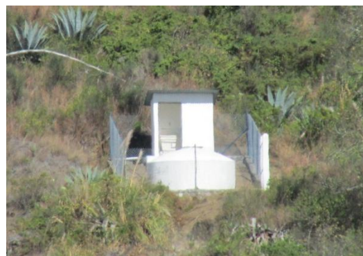
Fotografía 2.4.6 Planta de tratamiento de agua de la comunidad La Josefina.
