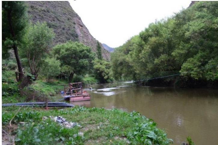
Foto 2.1.4 Sitio con riesgo de inundación en el sector "El Descanso".
